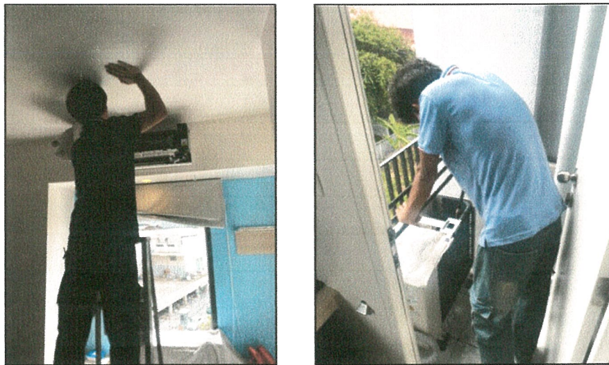
รูปภาพที่ 2.38 การล้างทำความสะอาดเครื่องปรับอากาศ
